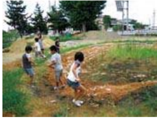
▲池の底に、粘土や田んぼの土を敷きました。
